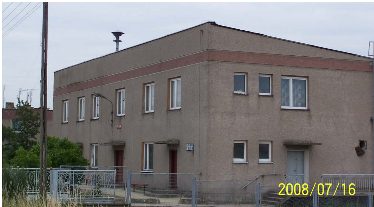
Zdjęcie 11 Budynek remizy OSP w Kidowie
